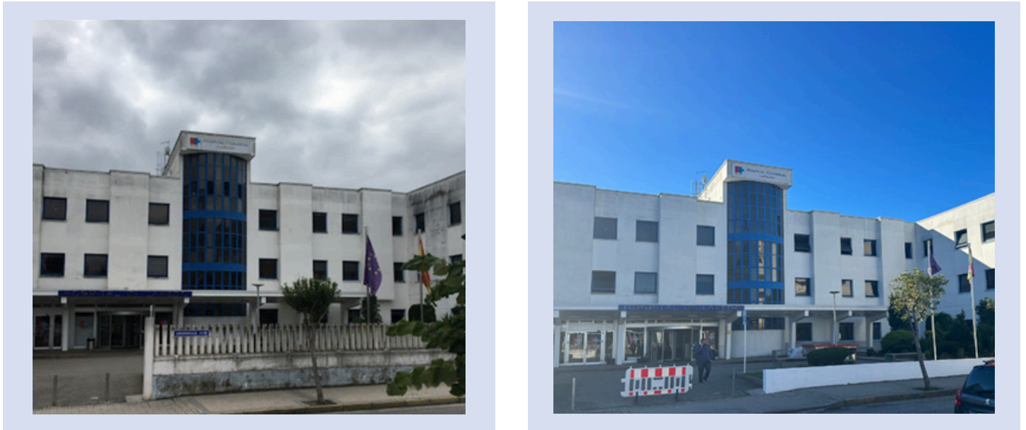
Imagen 10: fachada principal antes y después de la intervención
